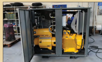
Plynový kompresor Mattei 55 kW určený pro kogenerační jednotku s mikroturbínou
